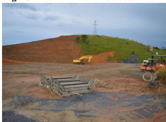
Figura 4 Aterro sanitário na cidade Três Rios
