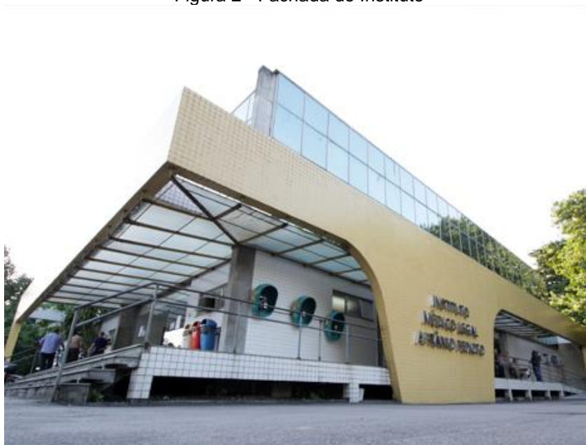
Figura 2 - Fachada do Instituto
