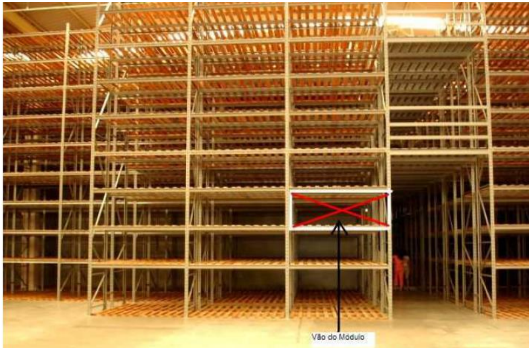
Figura 10 - Estanterias de dois níveis com um vão para 12 caixas em destaque
